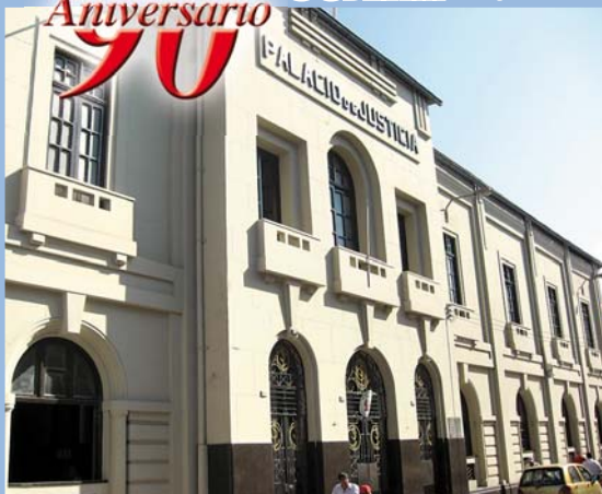
Antigua sede: calle San José N° 1052
